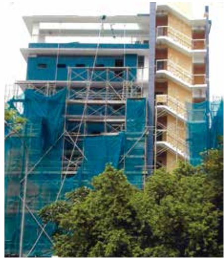
新大厦即将竣工
