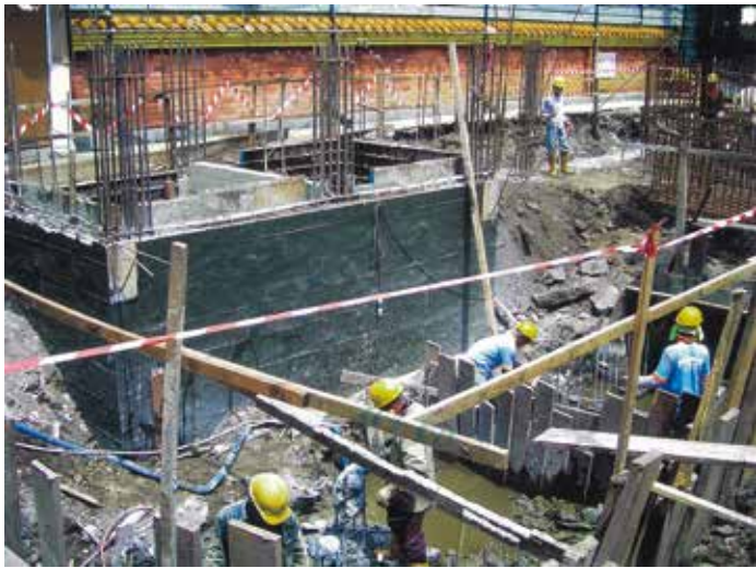
建筑中的新大厦
